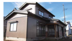
外観(北東側より)
