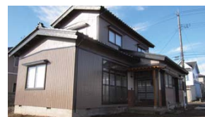
外観(北東側より)
